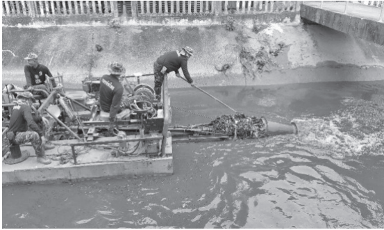
ภาพที่ 4 การลอกคลองด้วยเครื่องดันตะกอนเลน และรถขุดตักประกอบกับโป๊ะเรือ ที่มา: ภาพถ่ายโดยผู้วิจัย
