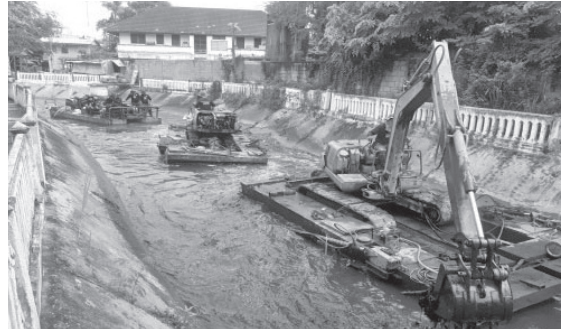
ภาพที่ 4 การลอกคลองด้วยเครื่องดันตะกอนเลน และรถขุดตักประกอบกับโป๊ะเรือ ที่มา: ภาพถ่ายโดยผู้วิจัย
