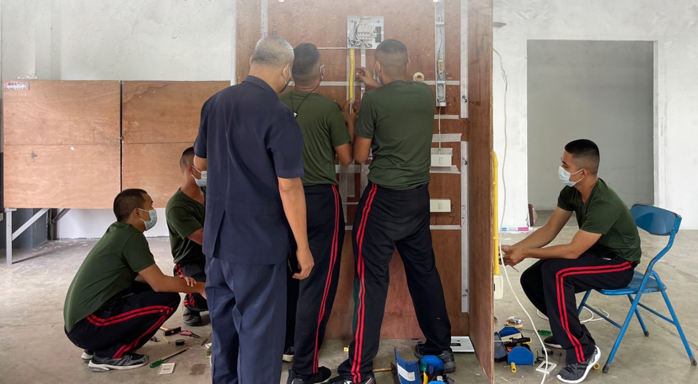
ท่อโลหะหนา (Intermediate Metal Conduit) หรือท่อ IMC
