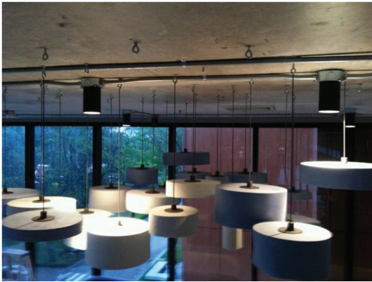
ภาพที่ 16 การติดตั้ง โดยเจาะฝังทุกซีเมนต์ยึดตะปูเกลียว ปลายห่วง
