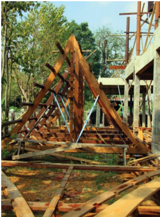
ภาพที่ 33 การปรุงโครงสร้างหลังคาเรือนไทย คุณชรินทร์ ธารพานิช จ.สุพรรณบุรี
