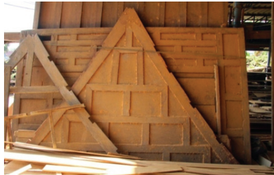
ภาพที่ 21 การซ่อมแซมองค์ประกอบส่วนต่างๆ ของเรือนจะทำการบูรณปฏิสังขรณ์ให้เรียบร้อยก่อนที่ระดับพื้นดินแล้วค่อยยกไปประกอบ
