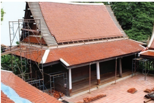
ภาพที่ 13 การใช้เสาเหล็กช่วยค้ำโครงสร้างหลังคา ขณะทำการเปลี่ยนเสา
