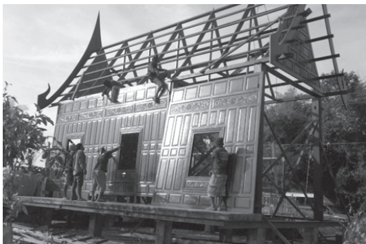
ภาพที่ 28 การติดตั้งแผงฝาเรือนไทย
