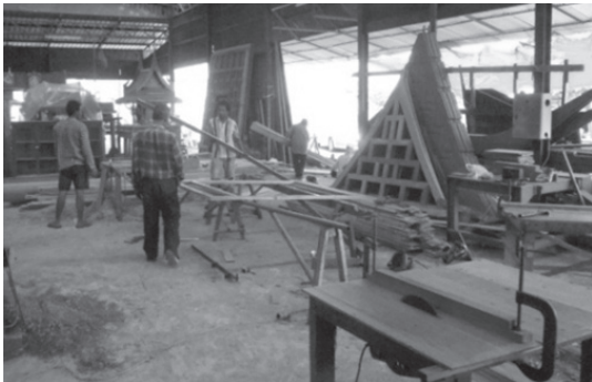
ภาพที่ 20 องค์ประกอบของเรือนทั้ง 2 หมู่ของเรือนไทยคุณอาริตา นุทกาญจนกุล ที่ถูกรื้อมาซ่อมแซม
