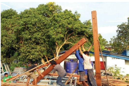
ภาพที่ 22 การยกเสาเอกเสาโทเรือนไทยเครื่องลั่น
