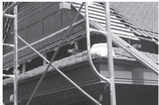
ภาพที่ 10 การเปลี่ยนไม้ส่วนเชิงกลอนและสะพานหนุเรือนไทย
