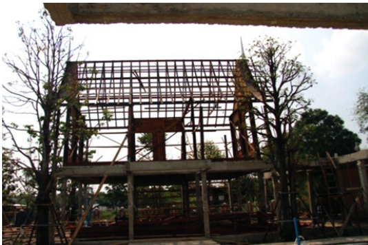
ภาพที่ 37 โครงสร้างเรือนตั้งแต่ฐานรากถึงพื้นที่ชั้นที่ 2 เป็นโครงสร้าง คสล. ส่วนตัวเรือนและหลังคาเป็นไม้
