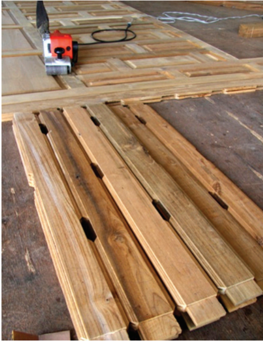
ภาพที่ 35 การเตรียมลูกตั้งสำหรับปรุงฝาปะกน
