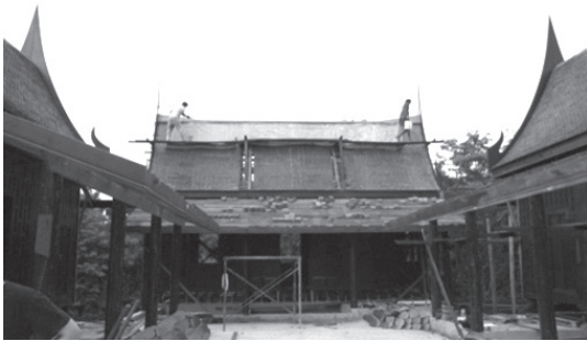
ภาพที่ 30 การมุงกระเบื้องดินเผาของหลังคาเรือนไทย
