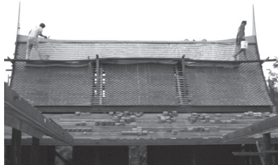
ภาพที่ 31 นั่งร้านที่วางอยู่บนแปลานสำหรับช่างปั้นปูนทับ สันหลังคา
