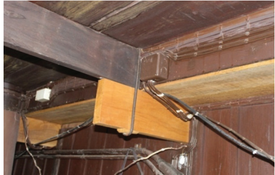
ภาพที่ 12 แสดงการเปลี่ยนไม้รอดส่วนพื้นพาไลและไม้กระดานปูพื้นใหม่
