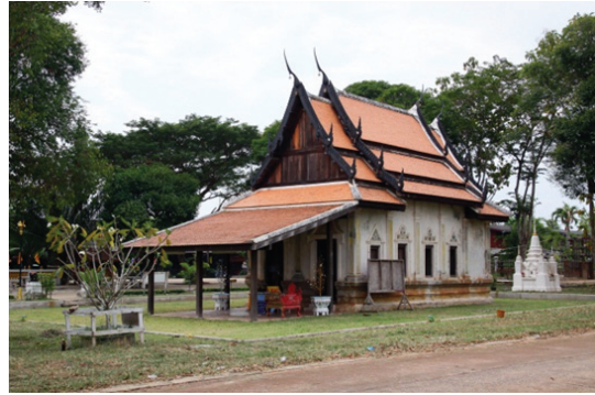
ภาพที่ 13 อุโบสถหลังเก่า วัดราชบัลลังก์ จังหวัดระยอง
