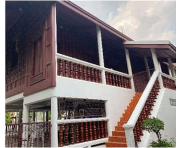
ภาพที่ 22 พาไลและใต้ถุนคอนกรีต หลังการบูรณะ พ.ศ. 2546 ทำให้ ภาพรวมของพระตำหนักเปลี่ยนไป ที่มา: ผู้เขียน, 2565
