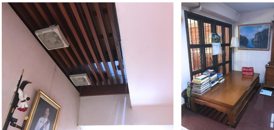
ภาพที่ 12 รายละเอียดการระบายอากาศห้องใต้ดินเรือนไทยอาจารย์ปิญญ์ สุวรรณศรี
