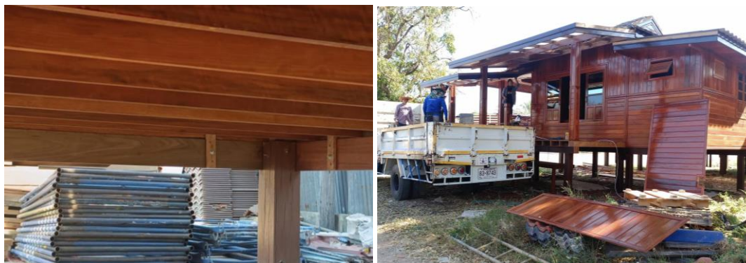
ภาพที่ 7 การออกแบบระบบขึ้นส่วนยอดประกอบเพื่อลดเวลาในการติดตั้ง
