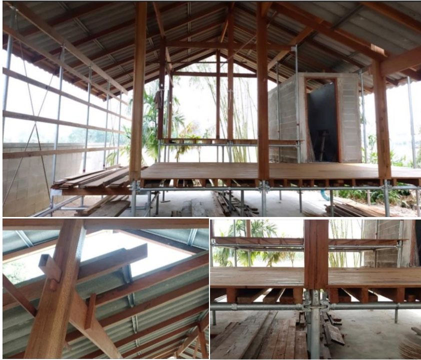
ภาพที่ 5 แสดงโครงสร้างยอดประกอบไม้ผสมเหล็ก กรณีศึกษาจังหวัดเชียงราย
