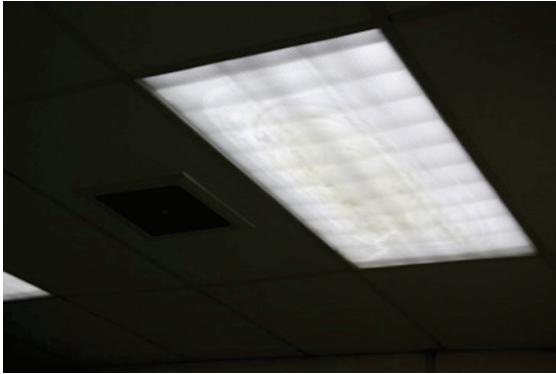
ภาพที่ 5 มีคราบน้ำที่รั่วซึมลงไปในดวงโคมจากระบบท่อน้ำประปาและท่อระบายน้ำเสียที่ตั้งอยู่บริเวณเหนือดวงโคมซึ่งยังมิได้รับการแก้ไข และมีความเสี่ยงในการเกิดไฟฟ้าลัดวงจร
