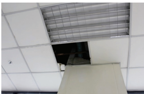
ภาพที่ 4 สภาพภายในห้องปฏิบัติการ (ซ้าย) และบริเวณทางเดินภายในอาคาร (ขวา) ซึ่งมีการรั่วซึมของน้ำจากท่อน้ำประปาและท่อระบายน้ำเสียที่บริเวณเหนือฝ้าเพดานลงมายังบริเวณด้านล่าง มีการเปิดฝ้าเพดานบางส่วนไว้ และยังไม่ได้มีการดำเนินการแก้ไขการรั่วซึมและฝ้าเพดานให้กลับมาอยู่ในสภาพที่ใช้งานได้ดีตามปกติ
