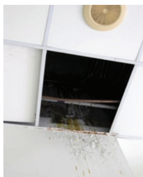
ภาพที่ 4 สภาพภายในห้องปฏิบัติการ (ซ้าย) และบริเวณทางเดินภายในอาคาร (ขวา) ซึ่งมีการรั่วซึมของน้ำจากท่อน้ำประปาและท่อระบายน้ำเสียที่บริเวณเหนือฝ้าเพดานลงมายังบริเวณด้านล่าง มีการเปิดฝ้าเพดานบางส่วนไว้ และยังไม่ได้มีการดำเนินการแก้ไขการรั่วซึมและฝ้าเพดานให้กลับมาอยู่ในสภาพที่ใช้งานได้ดีตามปกติ
