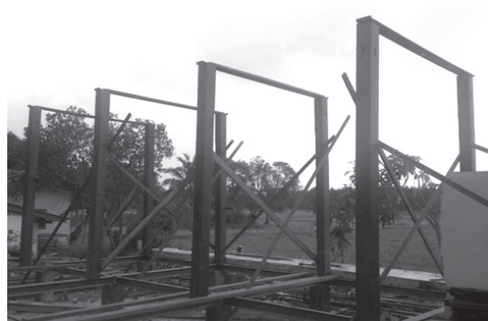
ภาพที่ 23 เมื่อยกเสาขึ้นเรียบร้อยแล้วจึงสวมข้อไม้ยึดหัวเสา
