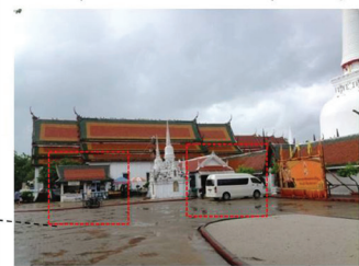
อาคารสำนักจัดผลประโยชน์ ศาลาขายดอกไม้รูปเทียน ป้ายตั้งอยู่บริเวณด้านหน้าทางเข้าวิหารคด ซึ่งเป็นอาคารที่สร้างขึ้นใหม่ ทำลายทัศนียภาพมุมมองทางเข้า
