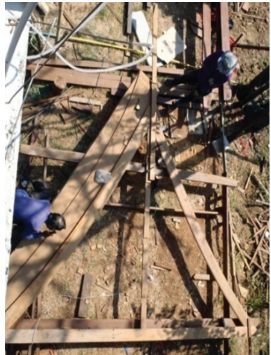
ภาพที่ 34 ช่างส่ง รอดสมจิตร จ.สุพรรณบุรี กำลังหา แนวเส้นหลังบ้านโดยใช้ไม้บางๆ ตัดโค้งสำหรับตีเส้น
