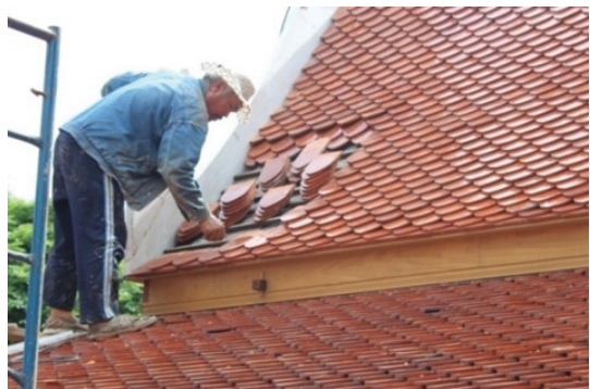
ภาพที่ 14 การมุงกระเบื้องดินเผากลับเข้าไปหลังจากซ่อมแซมหลังคาแล้วเสร็จ
