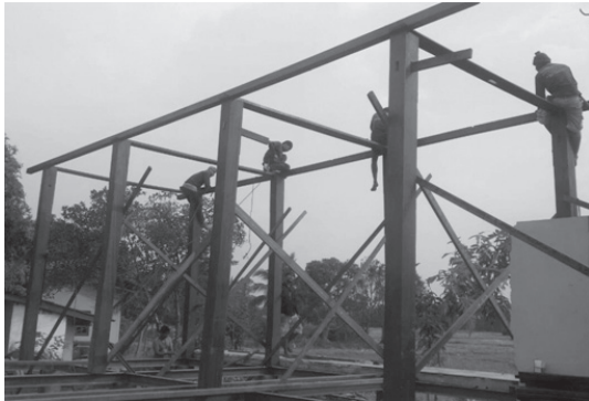
ภาพที่ 24 การสวมแปหัวเสาที่บนซื่อ และสวมเด้าไว้กับเสา
