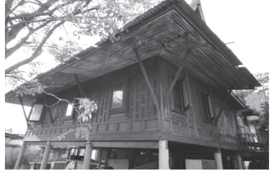
ภาพที่ 16 เรือนหมู่ที่ 2 ของพระอุโบสถวัดพระแก้ว ก่อนทำการ รื้อถอนตัวเรือนมีความกว้างระหว่างเสาของเรือน 3.15 เมตร
