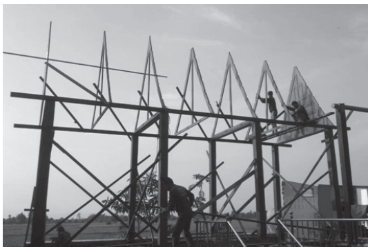
ภาพที่ 26 การติดตั้งใบตุง จันทัน และชุดจันทันพราง
