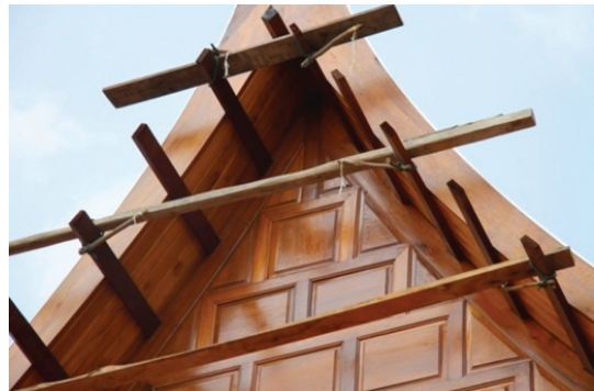
ภาพที่ 38 นั่งร้านสำหรับทาสีที่วางอยู่บนปลายของ แปลานที่แผงหน้าจั่ว
