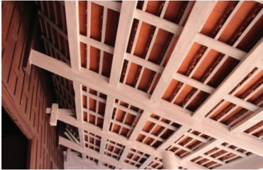
ภาพที่ 11 การเสริมจันทันพลาญบริเวณหลังคาพาไล เพื่อเสริมความแข็งแรงช่วยไม่ให้แปลนแอ่นตัว
