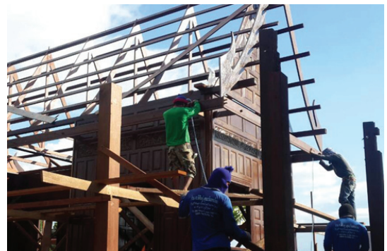
ภาพที่ 29 เมื่อติดตั้งแผงฝาเรียบร้อยจึงค่อยติดตั้ง
