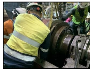
ภาพที่ 3 ตัวอย่างการซ่อมบำรุงเครื่องกังหันไอน้ำ
