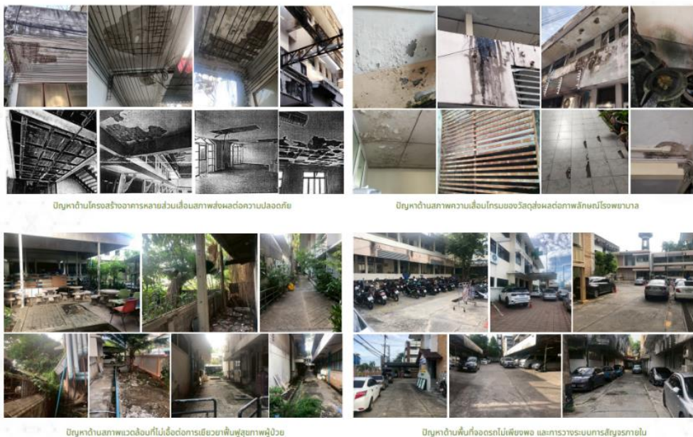
ภาพ 3 ผลการสำรวจสภาพกายภาพภายในโรงพยาบาลเมืองสงขลาแสดงปัญหาด้านโครงสร้าง และวัสดุ
