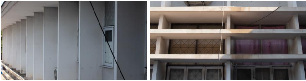
ภาพ 10 กันแสงแดดแนวตั้ง (ซ้าย) และกันแสงแดดแนวนอน (ขวา) ของตึกมทิดลอดุลยเดช ที่มา: ทัชชญา สังฆกุล, 2568
