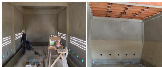
รูปที่ 13-14 เทคนิคกำแพงรางน้ำ และช่องลมภายในบ้านนก
