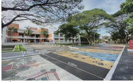
ภาพที่ 4 แสดงทางข้ามถนนทั่วไปกว้าง 6.00 เมตร สู่ทางเดินเข้าอาคารศูนย์เรียนรวมสมเด็จพระเทพฯ (บันทึกภาพถ่ายเดือนกรกฎาคม พ.ศ. 2565)
