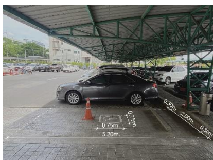
ภาพที่ 8 แสดงขนาดที่จอดรถคนพิการ แสดงพื้นที่จอดรถสำหรับผู้ใช้เก้าอี้ล้อและบริเวณขึ้นลงของผู้โดยสาร (ซ้าย)
