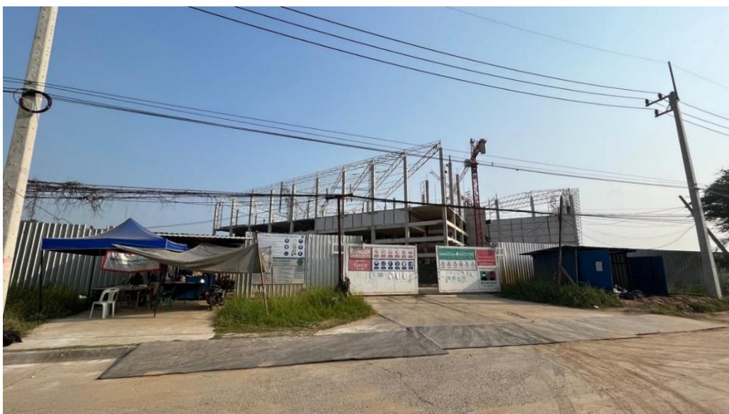
ภาพที่ 5 ภาพอาคาร Futorium ที่กำลังก่อสร้าง คาดว่าแล้วเสร็จใน พ.ศ. 2566
