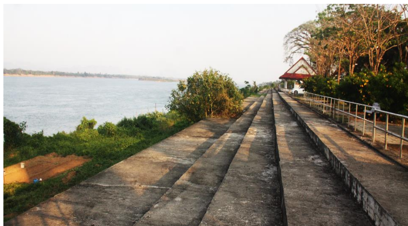
ภาพที่ 12 เขื่อนป้องกันตลิ่งแม่น้ำโขงรูปแบบที่ 2 (ที่มา: ผู้วิจัย, 2566)
