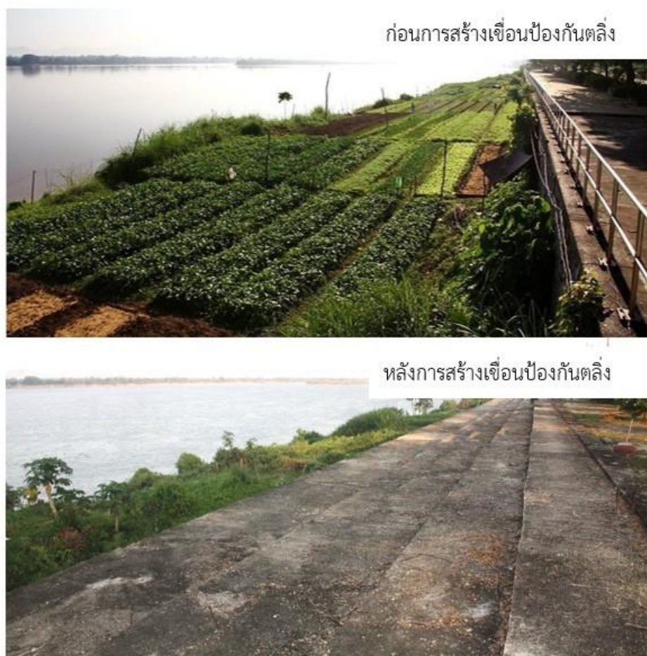
ภาพที่ 13 ตลิ่งแม่น้ำโขงก่อนและหลังการสร้างเขื่อนบริเวณหน้าทำการเทศบาลหลังเก่า (ที่มา: ผู้วิจัย, 2566)
