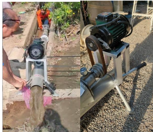
ภาพที่ 7 ติดตั้งมอเตอร์กับแท่นวางมอเตอร์พร้อมชุดควบคุม
