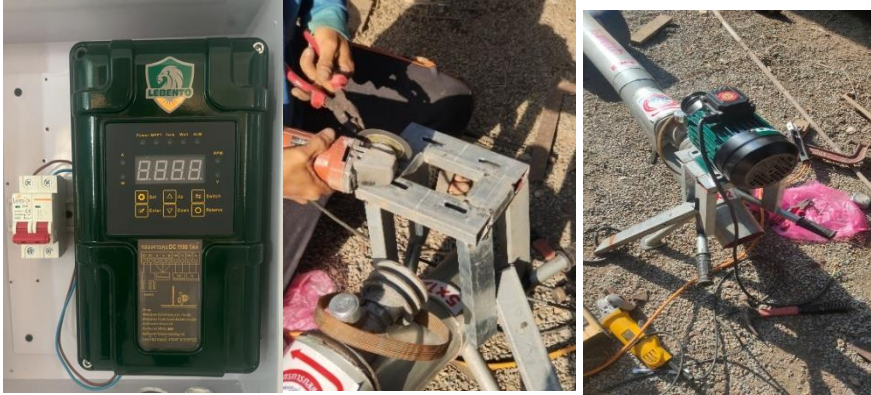
ภาพที่ 6 ติดตั้งมอเตอร์กับแท่นวางมอเตอร์พร้อมชุดควบคุม
