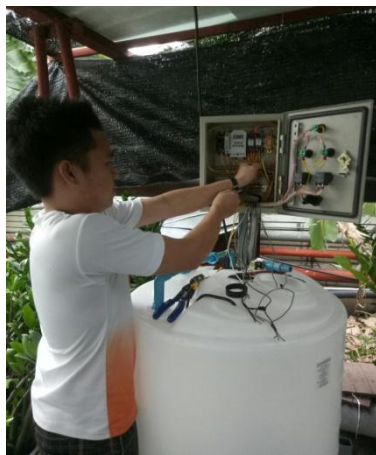
ภาพที่ 3 ติดตั้งตู้คอนโทรล โซลินอยด์วาล์ว สวิตช์ลูกลอย และ ท่อน้ำ
