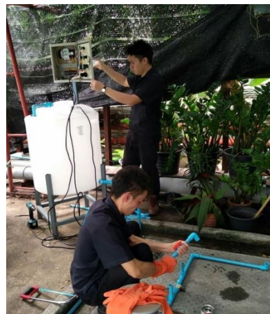
ภาพที่ 3 ติดตั้งตู้คอนโทรล โซลินอยด์วาล์ว สวิตช์ลูกลอย และ ท่อน้ำ
