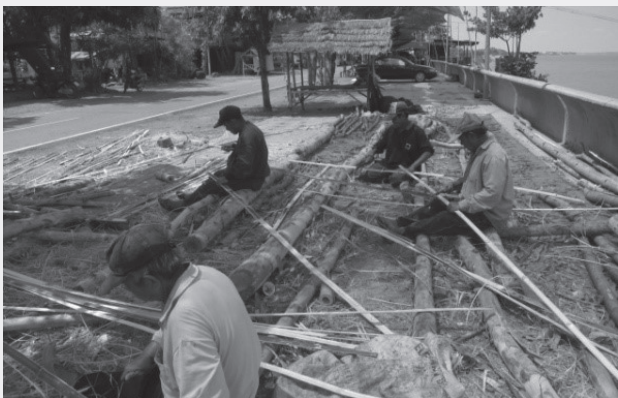
ภาพที่ 7 การจัดเตรียมวัสดุอุปกรณ์ สำหรับการสร้างสะพาน
