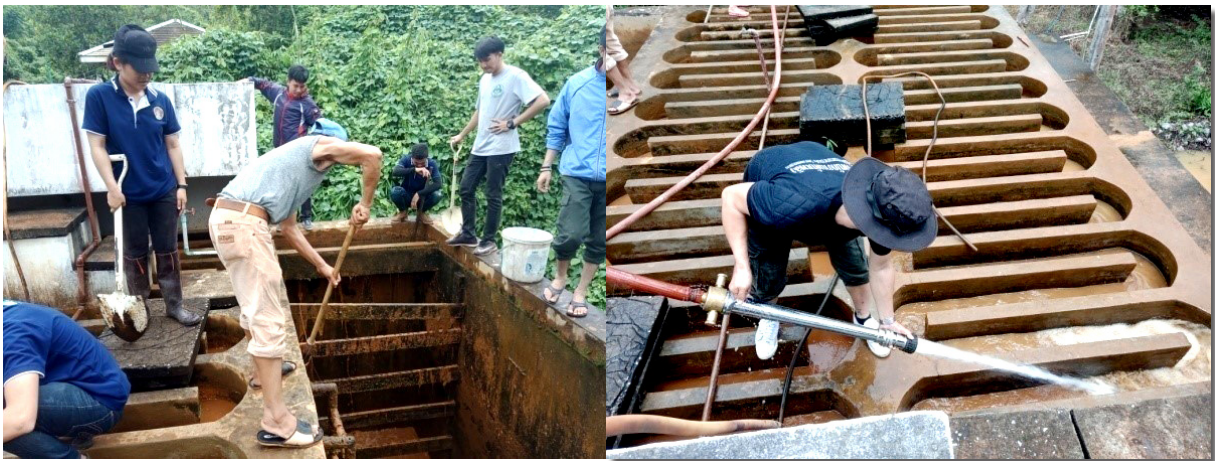
ภาพที่ 6 การล้างระบบประปา ณ ระบบกรองแหล่งน้ำดิบของระบบการผลิตประปาบ้านกอไผ่ใหญ่ หมู่ที่ 1
