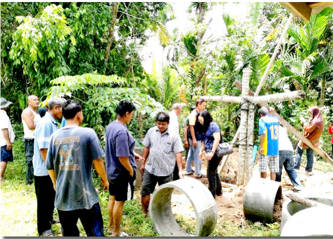
ภาพที่ 3 การปรับพื้นที่ ขุดหลุม ติดตั้งบ่อหมักแก๊สชีวภาพ
