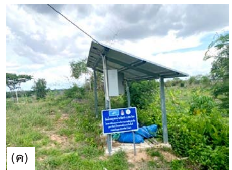
ภาพที่ 5 การเพิ่มแหล่งน้ำเพื่อการผลิตผัก ก) บ่อบาดาลขนาดบ่อ 6 นิ้ว ข) หอส่งน้ำพร้อมถังเก็บน้ำ และ ค) แผงโซลาร์เซลล์เพื่อใช้สูบน้ำการเกษตร
