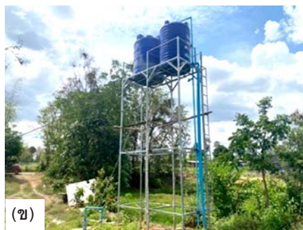
ภาพที่ 5 การเพิ่มแหล่งน้ำเพื่อการผลิตผัก ก) บ่อบาดาลขนาดบ่อ 6 นิ้ว ข) หอส่งน้ำพร้อมถังเก็บน้ำ และ ค) แผงโซลาร์เซลล์เพื่อใช้สูบน้ำการเกษตร
