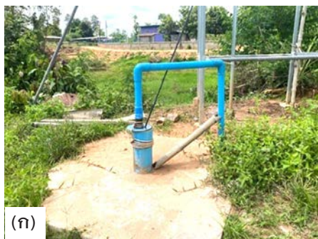
ภาพที่ 5 การเพิ่มแหล่งน้ำเพื่อการผลิตผัก ก) บ่อบาดาลขนาดบ่อ 6 นิ้ว ข) หอส่งน้ำพร้อมถังเก็บน้ำ และ ค) แผงโซลาร์เซลล์เพื่อใช้สูบน้ำการเกษตร
