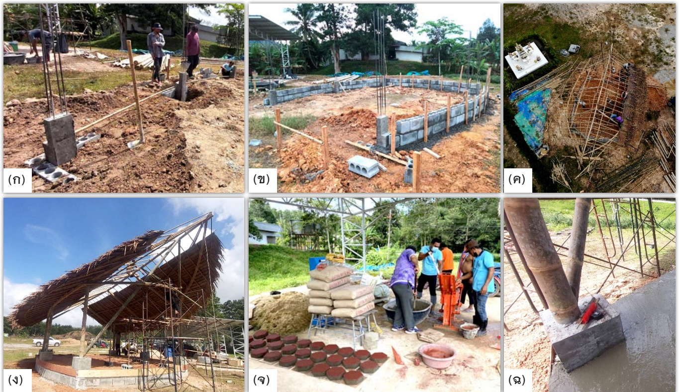
ภาพที่ 8 (ก) การปรับพื้นที่และจัดเตรียมไม้ไผ่ (ข) การจัดทำฐานศาลา (ค) โครงสร้างหลังคาไม้ไผ่ (ง) การมุงหลังคาด้วยทางจาก (จ) การผสมปูนกับเศษจากเพื่อทำบล็อกทางเท้า และ (ฉ) ฐานโครงสร้างศาลารักษ์โลก
