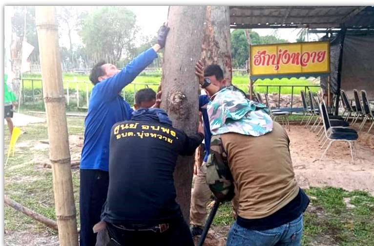
ภาพที่ 9 การก่อสร้างศูนย์เรียนรู้
