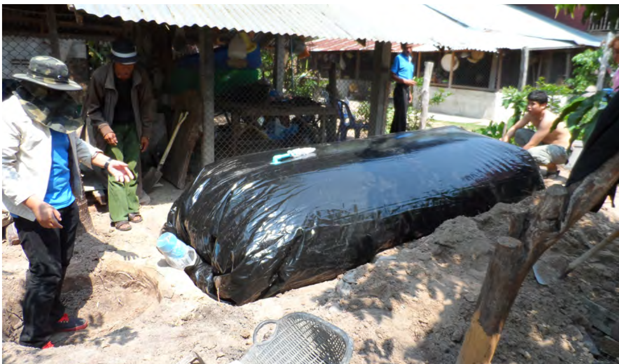
ภาพที่ 2 การติดตั้งถังก๊าซชีวภาพจากมูลสัตว์ที่บ้านพ่อบุญมา วิชาติ ที่บ้านโนนเค็ง ตำบลคำขวาง อำเภวารินชำราบ ที่ได้รับความร่วมมือในการติดตั้งจากพลังงานจังหวัดอุบลราชธานี ทำให้ตัดค่าแก๊สหุงต้มได้
