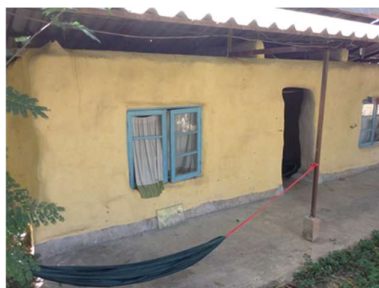
ภาพ 1 บ้านฟางอัดก้อน ฉาบด้วยดิน โครงการ พันพรรณ อำเภอมะแม่ง จังหวัดเชียงใหม่
