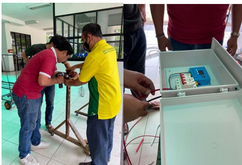
ภาพ 12 ขั้นตอนการติดตั้งมอเตอร์และต่อสาย Charger controller ไปยังแผ่นโซลาร์พานเนล
