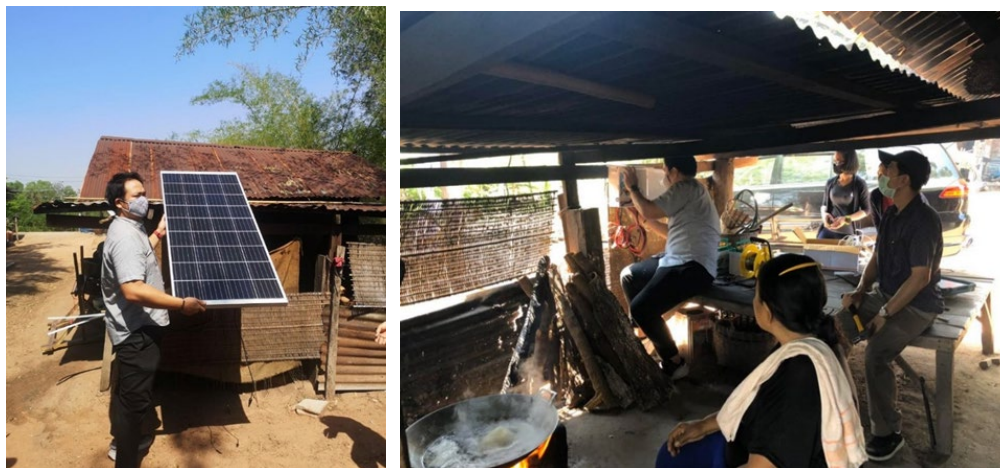
ภาพ 13 คูสถานที่ในการวางแผนโซล่าพาแนลในจุดที่รับแสงได้ดีและเชื่อมต่อไปยัง Charger controller
