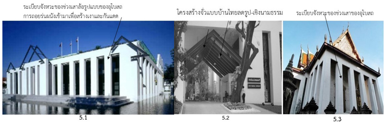
ภาพ 5 การวิเคราะห์อาคารทำเนียบองคมนตรี: 5.1 และ 5.2 ทำเนียบองคมนตรี 5.3 อุโบสถวัดพระแก้ววังหน้า ใช้วัสดุอิฐโชว์แนว
