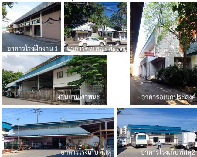
ภาพ 6 รูปถ่ายสภาพของอาคารเดิม
