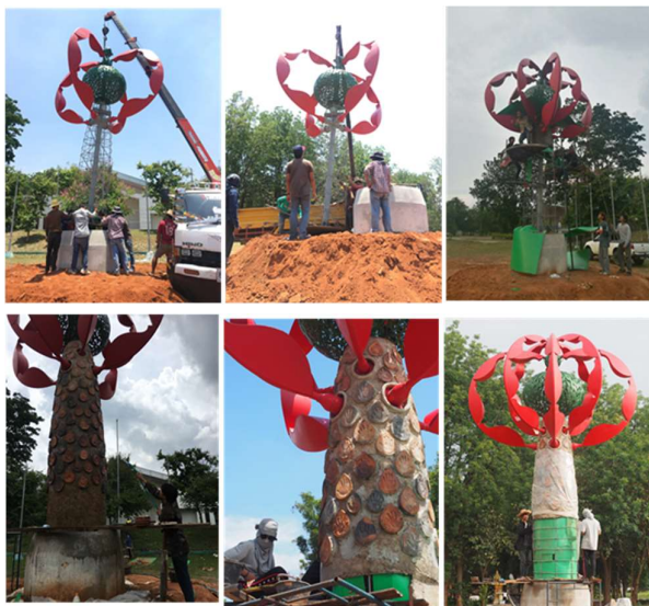
ภาพ 10 การติดตั้งผลงานประติมากรรมและเก็บรายละเอียด
