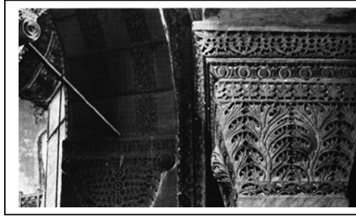
ภาพ 12 บัวปลายเสาแบบไบแซนไทน์ หรือบัวตะกร้า (Basket Capital) ในมหาวิหารฮาเจีย โซเฟีย (ที่มา Sir Banister Fletcher's History of Architecture. Cruickshank, Dan, editor. 20 th ed. (Oxford: Architectural Press, 1998.), p.304)
