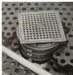
ภาพ 10 แสดงฝาช่องท่อกลม (Round drain หรือ Deck drain) ควรเรียบเสมอกับผิวบนของชั้นระบายน้ำ (Theodore Osmundson, 1999)
