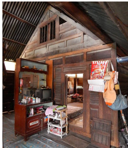
ฝากันห้องแบบฝาดำผ้ามีजूกรุกันห้องเจาะเป็นช่องอากาศ (ถ่ายภาพโดย : ปรียานุช คำสนอง, 2558)
