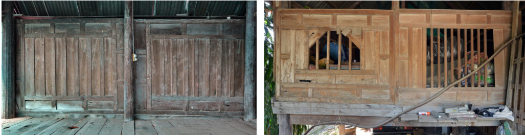
ภาพที่ 10 แสดง “ฝาปะกน” เป็นระบบแผ่นฝาประกอบวางบนพริ้ง ของเรือนกรณีศึกษาที่ 4 ที่มา: รุ่งกิจ เจริญวัฒน์, 2557
