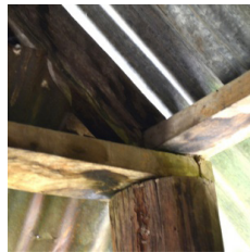
ข้อและแปหัวเสาสามกับหัวเทียนที่ศูนย์กลางเสา
