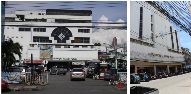
ภาพที่ 4 แสดงลักษณะอาคารห้างสรรพสินค้า (ซ้าย) เป็นทางเข้าออกหลักของห้างสรรพสินค้าติดกับถนนอัญญาณ์ (ขวา) ทางเข้าออกด้านลานจอดรถติดกับถนนจักรี
