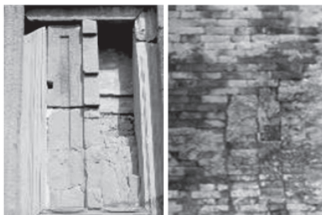
ภาพที่ 15 การใช้หินทราย ภาพที่ 16 ผนังรับน้ำหนักก่อ บริเวณโครงสร้างหลักเพื่อใช้ ด้วยอิฐภายในปราสาท ถ่ายน้ำหนักของอาคาร
