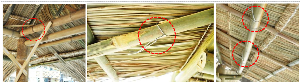
ภาพที่ 12 แสดงการเชื่อมต่อภายนอกลำไม้โดยใช้ลวดมัดลำไม้หรือไม้ซีกเข้ากับวัสดุถุง
