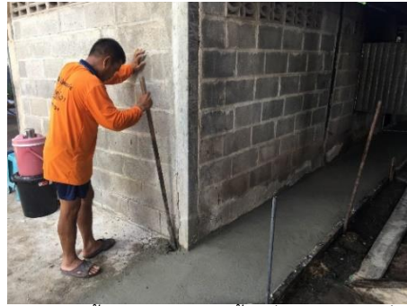
ข) การเทพื้นซีเมนต์ ทำร่องน้ำ เพื่อป้องกันการลื่น
