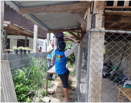
ก) การต่อเติมชายคารอบบ้าน เพื่อป้องกันฝน
