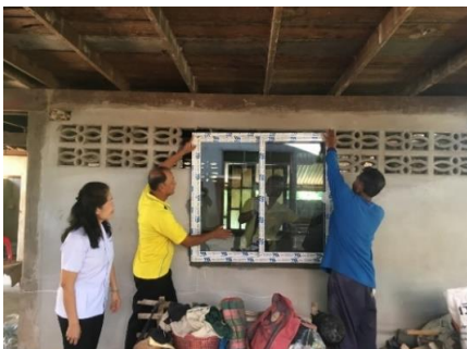
ช) เปลี่ยนหน้าต่างเป็นแบบกระจกบานเลื่อน
