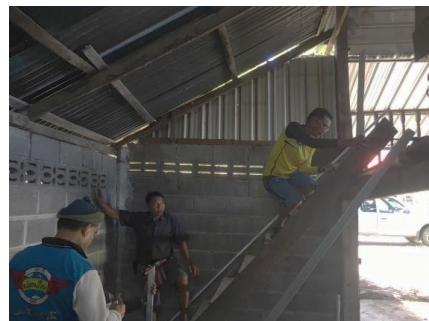
ซ) ซ่อมแซมและทำราวจับบันได ตามการใช้งาน
