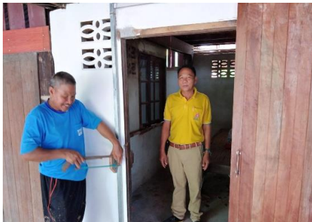
จ) การปรับขนาดให้กว้างขึ้นและเป็นแบบเลื่อน
