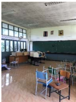
(ง) ตัวอย่างวัสดุอาคารอยู่ในสภาพไม่ พร้อมใช้งาน
