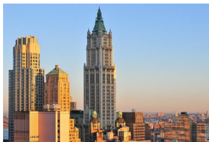
ภาพที่ 14 อาคาร วูลเวิร์ธ ทาวเวอร์ (Woolworth Tower), 1913
