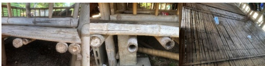
ภาพที่ 4 ลักษณะโครงสร้างพื้นฝากไม้ไผ่
