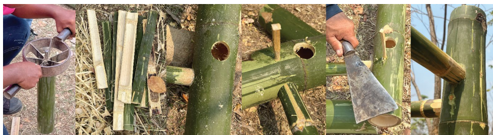
ภาพที่ 7 การผ่าซีกด้วยจี่ปาผ่าไผ่และการยึดโครงสร้างไม้ไผ่แบบตอกสลัก
