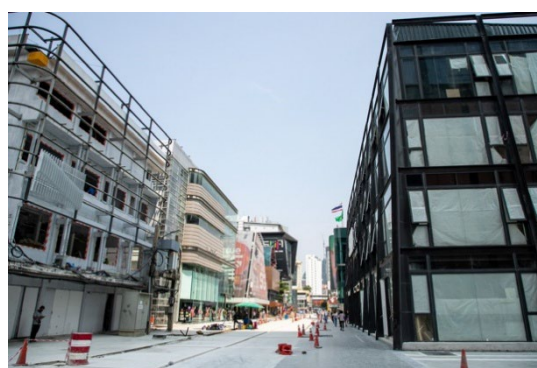
ภาพที่ 2 การปรับปรุง façade อาคาร และระบบสายไฟ แรงต่ำและสาย fiber optic เข้าอาคาร ที่มา: สำนักงานจัดการทรัพย์สิน จุฬาลงกรณ์มหาวิทยาลัย
