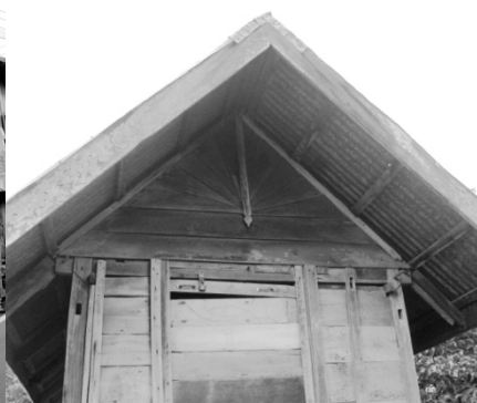
ภาพที่ 13 เล้าข้าวมุงหลังคาด้วยกระเบื้องคอนกรีตแบบเก่า (ซ้าย) เล้าข้าวแบบดั้งเดิมที่เปลี่ยนหลังคาจากแปนเกล็ดไม้มาเป็นสังกะสี (กลาง) และเล้าข้าวที่ทำ จากไม้ไผ่ทั้งหลัง (ขวา)
