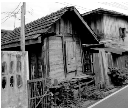
ภาพที่ 13 เล้าข้าวมุงหลังคาด้วยกระเบื้องคอนกรีตแบบเก่า (ซ้าย) เล้าข้าวแบบดั้งเดิมที่เปลี่ยนหลังคาจากแปนเกล็ดไม้มาเป็นสังกะสี (กลาง) และเล้าข้าวที่ทำ จากไม้ไผ่ทั้งหลัง (ขวา)
