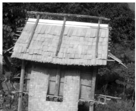
ภาพที่ 13 เล้าข้าวมุงหลังคาด้วยกระเบื้องคอนกรีตแบบเก่า (ซ้าย) เล้าข้าวแบบดั้งเดิมที่เปลี่ยนหลังคาจากแปนเกล็ดไม้มาเป็นสังกะสี (กลาง) และเล้าข้าวที่ทำ จากไม้ไผ่ทั้งหลัง (ขวา)
