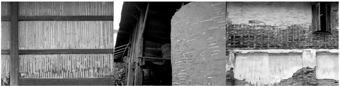
ภาพที่ 14 ฝาไม้ไผ่ฉาบด้วยดินเปื้อนแบบต่างๆที่สำรวจพบในภาคอีสาน ซึ่งสามารถรักษาไม้ไผ่คงทนอยู่ได้หลายสิบปี
