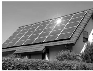
(2) บนหลังคา
