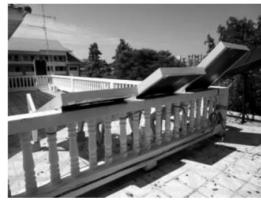
(2) การติดตั้งแผงบานเกล็ด
