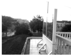
(1) บ้านผลิตพลังงานแสงอาทิตย์ที่ติดตั้ง
