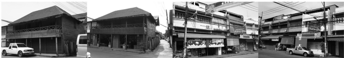
ภาพที่ 9 เปรียบเทียบอาคารก่อนและหลังการทาสีใหม่
