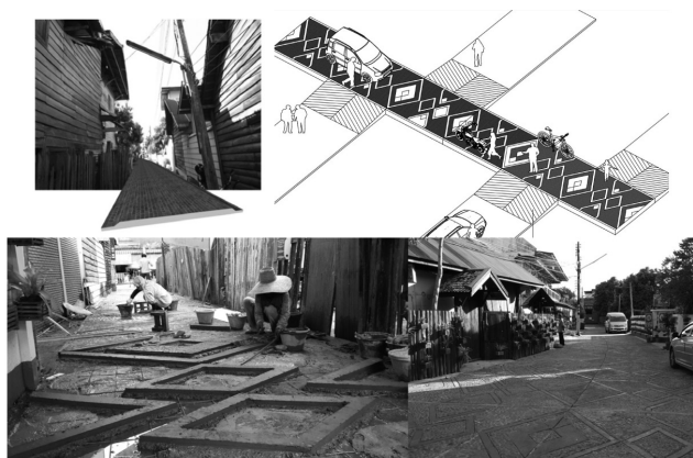
ภาพที่ 11 รูปแบบและลวดลายผิวถนน (บน) เทคนิคก่อสร้างและผลงานก่อสร้างจริง (ล่าง)
