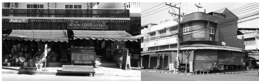
ภาพที่ 15 ผลงานการติดตั้งผ้าใบกันแดดที่ดำเนินการแล้วเสร็จ
