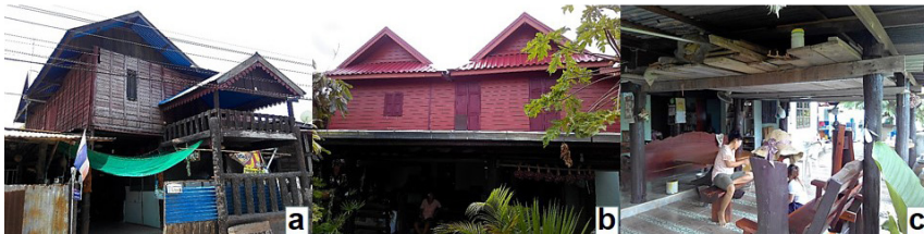
ภาพที่ 11a การนำฝาโบราณมาประกอบเป็นฝาเรือน
