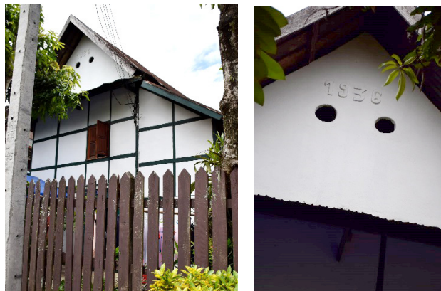
ภาพที่ 13 อาคารพักอาศัยยุคก่อนอาณานิคมประเภทที่ 2 อาคารกึ่งไม้ (Half-timber House)
