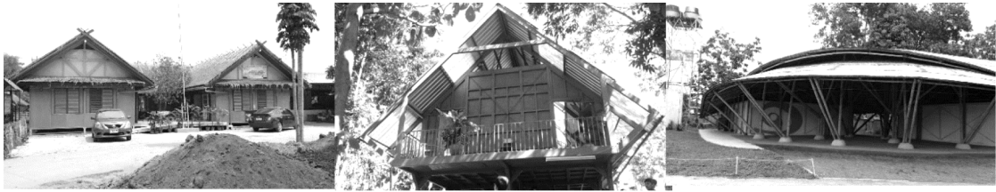
ภาพที่ 20 อาคารเรียนต้านแผ่นดินไหว บ้านท่าฮ่อ (ซ้าย) บ้านห้วยสำนยาว (กลาง) และบ้านปากอ้อม (ขวา)
