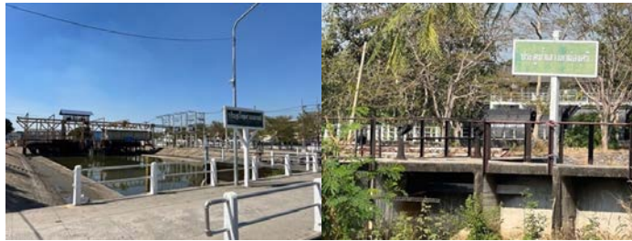
ภาพที่ 2 ประตูน้ำจุฬาลงกรณ์และประตูน้ำเสาวภาผ่องศรี ที่ใช้ในการบริหารจัดการน้ำในคลองรังสิตประจักษ์
