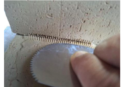
ภาพที่ 17 แสดงการขุดผิวลักษณะพื้น หริบริเวณที่จะต่อประกอบ ที่มา : อภิญา วิไล 2568
