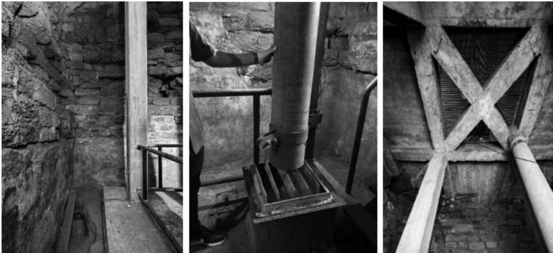
ภาพที่ 2 กรุชั้นบนมีพัดลมระบายอากาศจากกรุชั้นล่างสู่กรุชั้นกลางและระบายผ่านท่อสู่กรุชั้นบน
